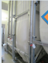
Loading pipe from truck Da tubo di carico a bordo silo e da autocisterna.
